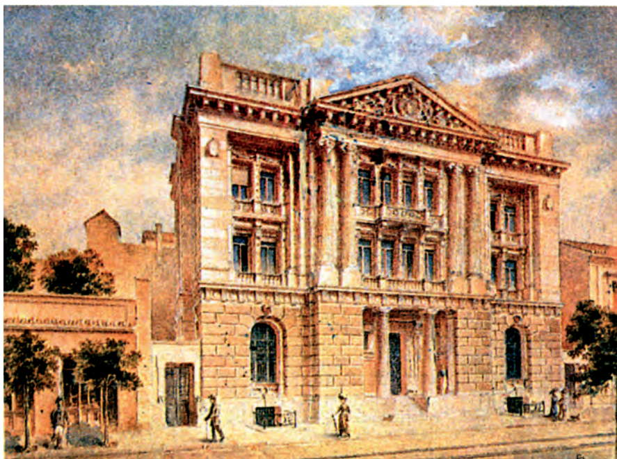
Αθήνα, Νεοκλασικό κτίριο
